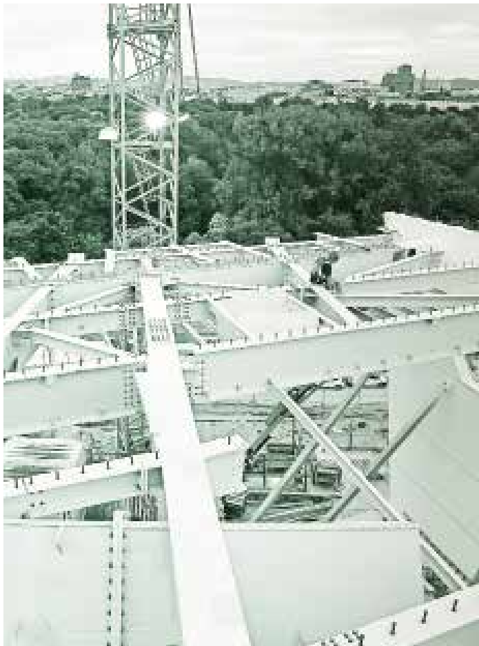
Library and Learning Center: Stahlträgerrost im Bereich der Auskragung Structural steel grillage in the cantilever area
