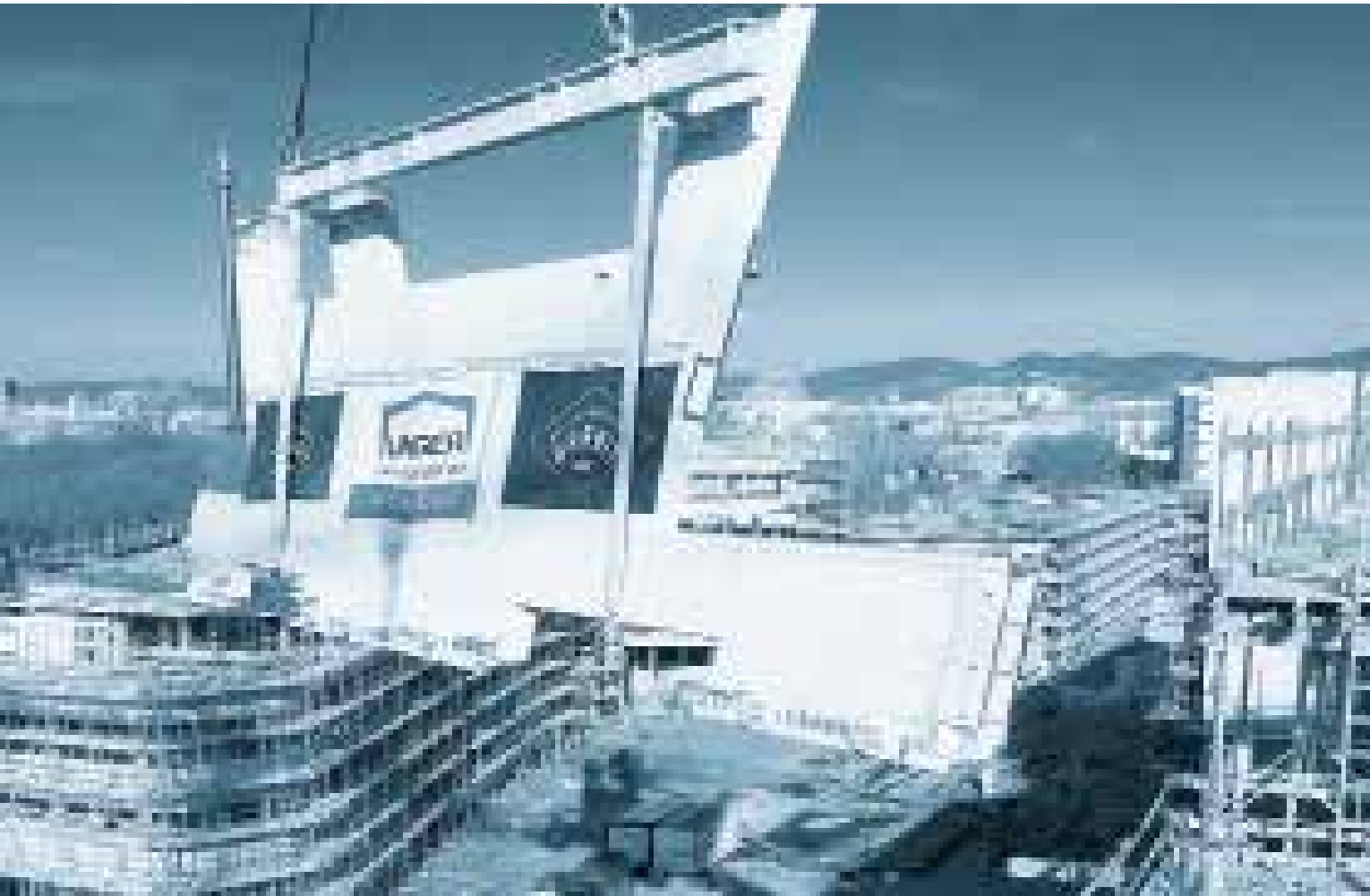
Library and Learning Center: Einheben des Hauptstahlfachwerkes Hoisting the steel frame
