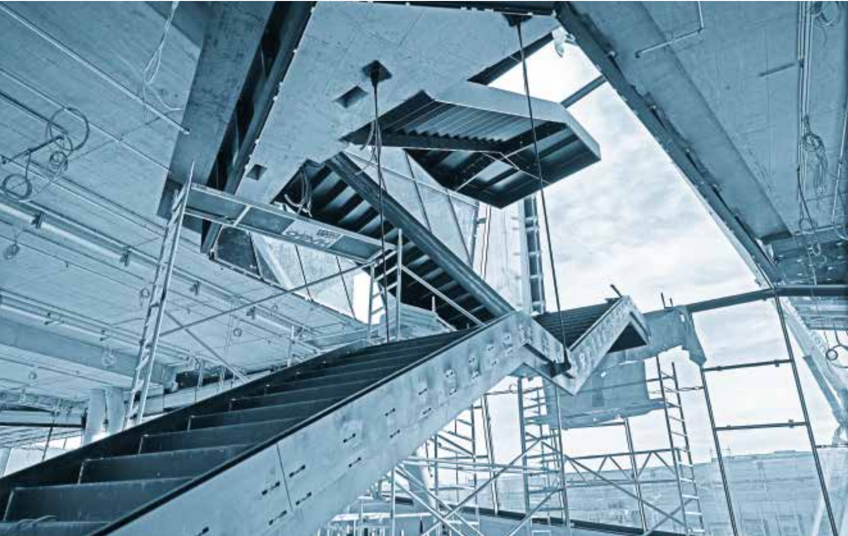
Teaching Center: Ausragendes Stiegenhaus als Stahlkonstruktion Cantilevering steel stair construction
